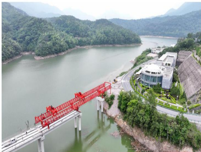
(2025 年 5 月,洪屏抽水蓄能电站二期项目——鹭鸶坳大桥预制 T 梁架设施工现场)
