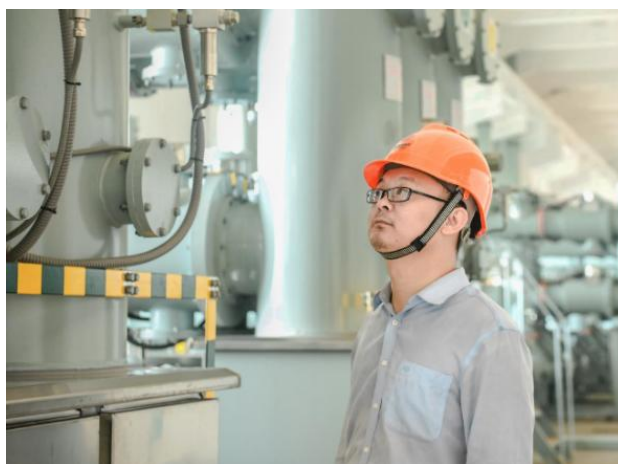
(钟波巡检设备)
