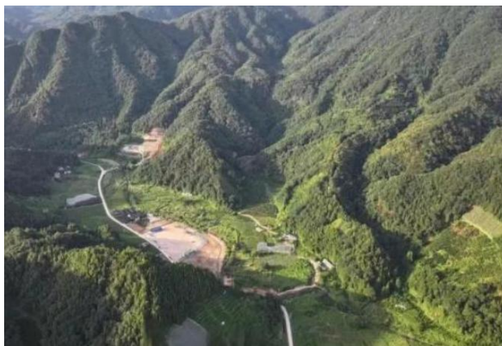
(寻乌抽水蓄能电站项目地形概貌)
